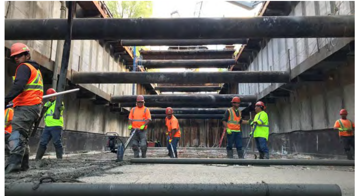
Crews pour the Kenilworth tunnel leveling slab
